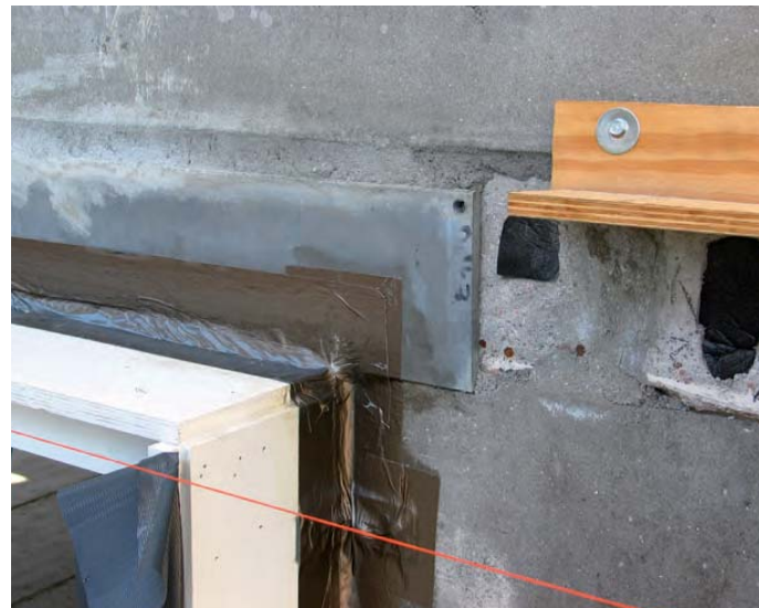
Voor afdichting van luchtlekken wordt gebruikgemaakt van schuimband, tapes, flexibele kit en flexibel porschuim.
