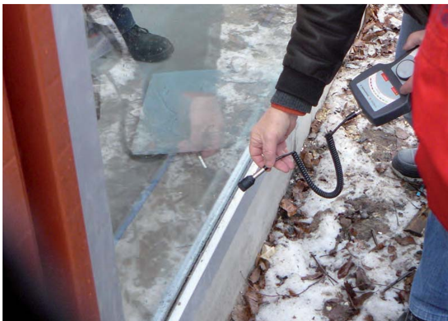
Luchtlekken zijn op te sporen met verschillende technieken, zoals de blowerdoortest, warmtebeelden en – zoals hier – ultrasoonstechniek.
